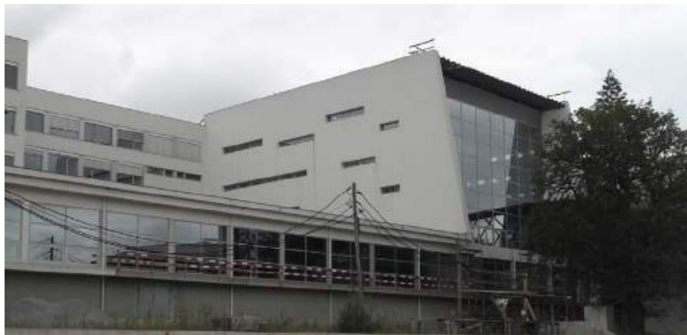
COORDENAÇÃO E FISCALIZAÇÃO DE OBRA COORD. DE SEGURANÇA
