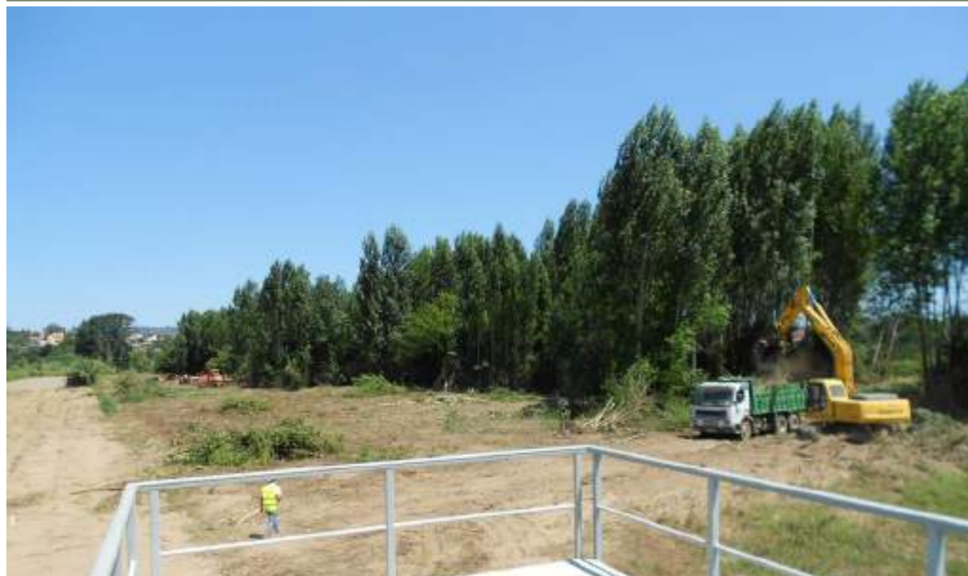
COORDENAÇÃO E FISCALIZAÇÃO DE OBRA COORD. DE SEGURANÇA
