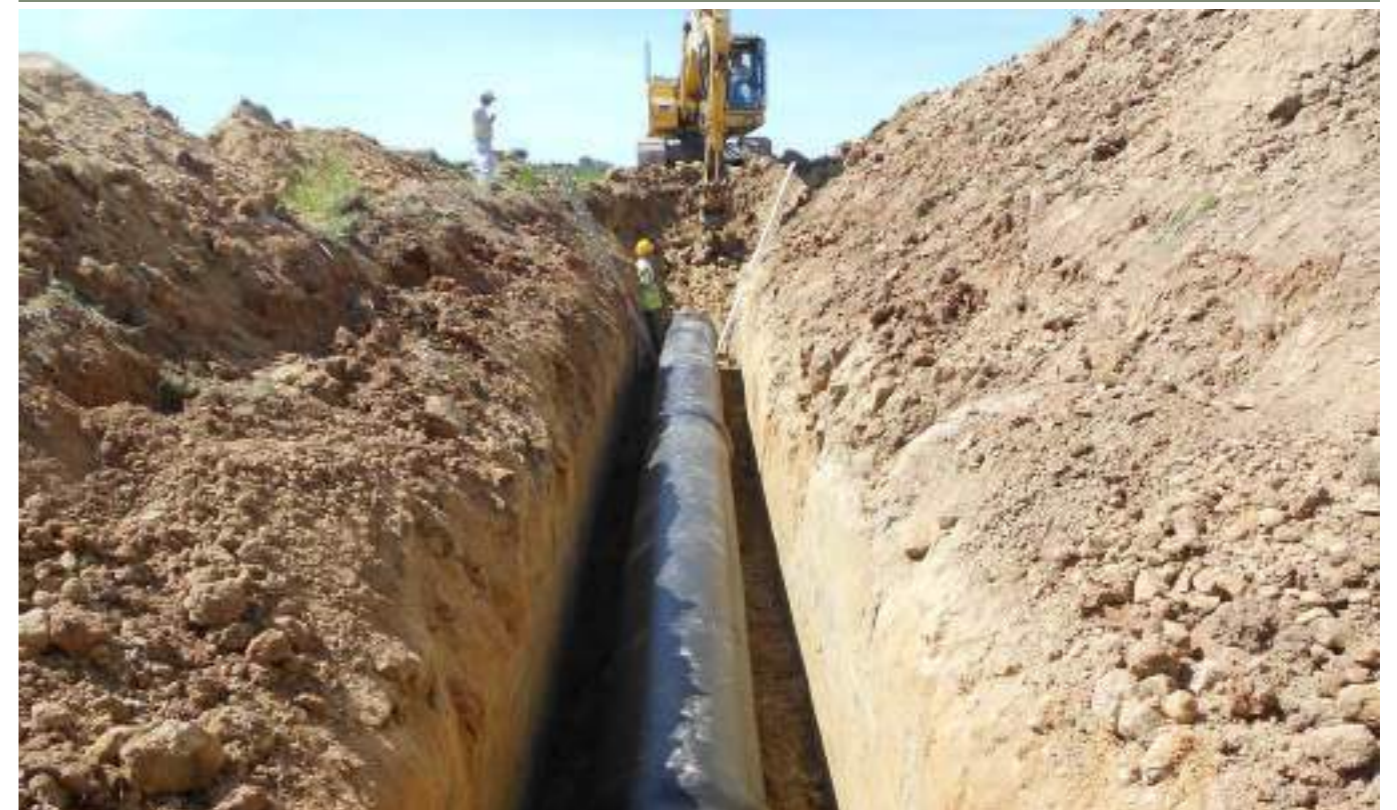
COORDENAÇÃO E FISCALIZAÇÃO DE OBRA COORD. DE SEGURANÇA
